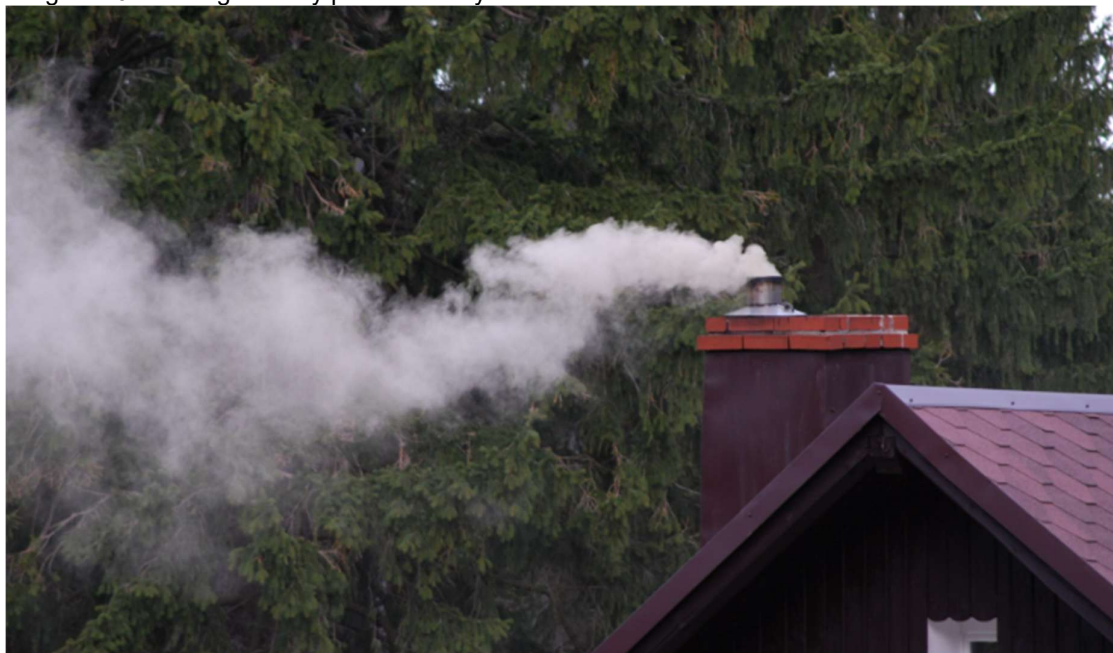
Fotografia 6. Dom ogrzewany paliwami stałymi
