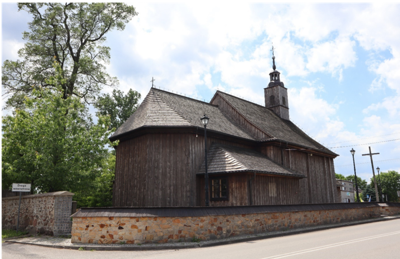
Fot. 6) Kościół św. Klemensa w Lgocie Wielkiej, widok na prezbiterium zdjęcie wykonane w kierunku północno – wschodnim.
