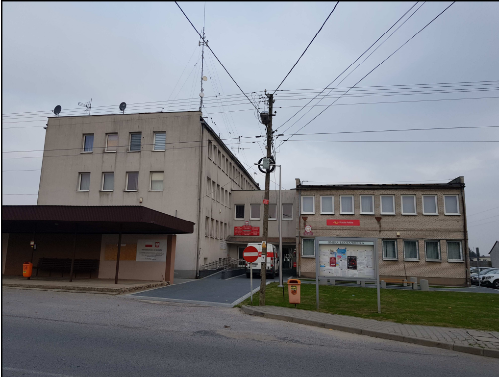
Rysunek 7 Widok na obszar Nr 5 od strony drogi powiatowej Nr 3947E
